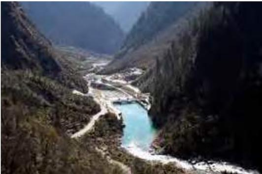
Das Projekt generiert Elektrizität aus vier Turbinen mit jeweils 100 MW und benutzt dabei nur die ungehinderte und kraftvolle Leistung des Flusses Alaknanda. Es wurden keine Staudämme Fluss auf- und abwärts der Stromanlage gebaut. Dies hätte zu einer Umsiedelung der lokalen Einwohner oder zu einer Beschädigung des lokalen Ökosystems führen können, wie es bei so vielen anderen grossen Wasserkraftwerkprojekten bereits vorgekommen ist.
